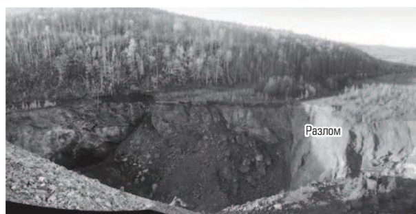
Рис. 13. Зона обрушения земной поверхности летом 2019 г. (фото с лежащего бока рудной зоны)
