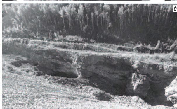
Рис. 11. Зоны неупругих деформаций в потолочине у земной поверхности, в междукамерных и междуэтажных целиках по результатам расчетов (а) и провал потолочины и разрушение верхних частей междукамерных целиков у земной поверхности в зонах неупругих деформаций (б) (фото с лежачего бока рудной зоны, сентябрь 2018 г.)
