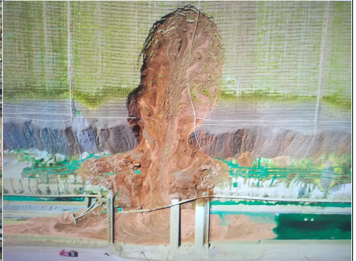
Día del Deslizamiento
