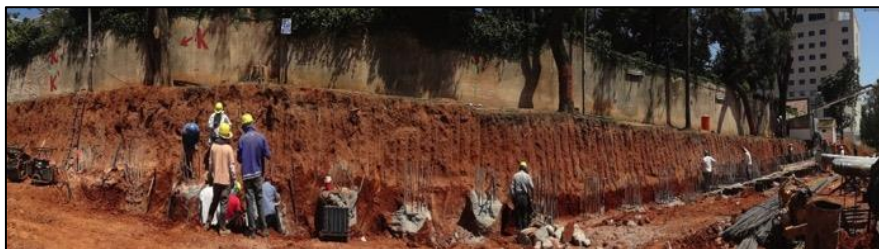
Figura 7. Vista panorámica de un frente contenido con pilotes.
