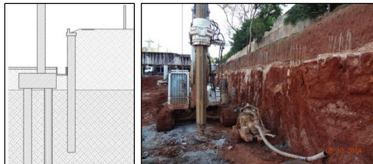
Figura 6. Combinación de pantalla de pilotes con fundaciones de las estructuras principales.
