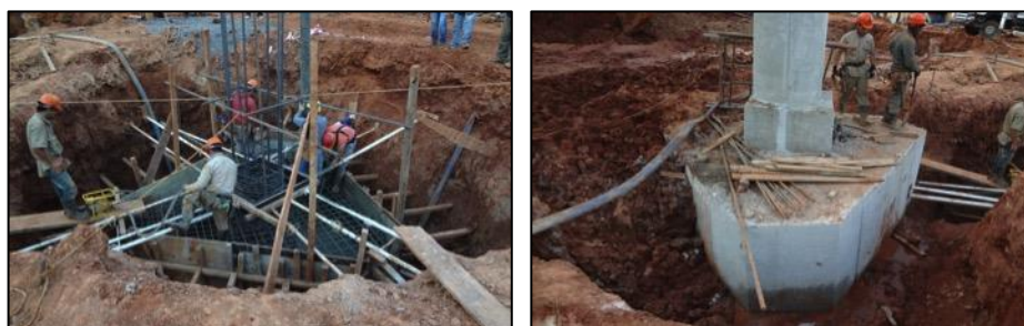
Figura 3. Cabezales de tres pilotes construidos en el proyecto.
