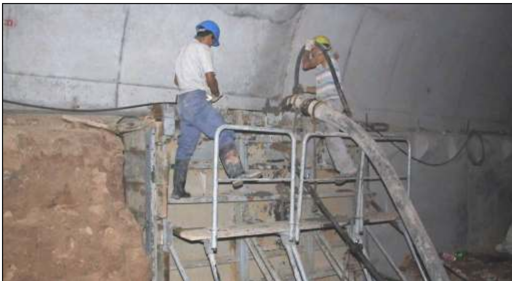
Fig. 8. Hormigonado de un hastial en el método Belga. Línea H, 2002.
