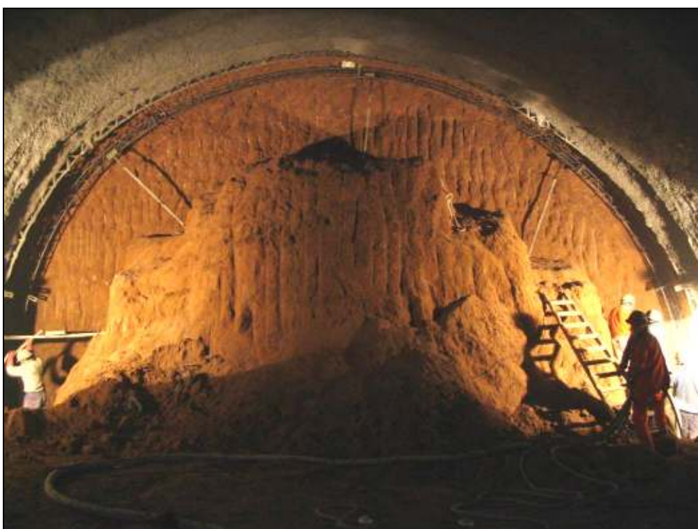
Fig. 3. Túnel Línea B, frente completo, 2005.
