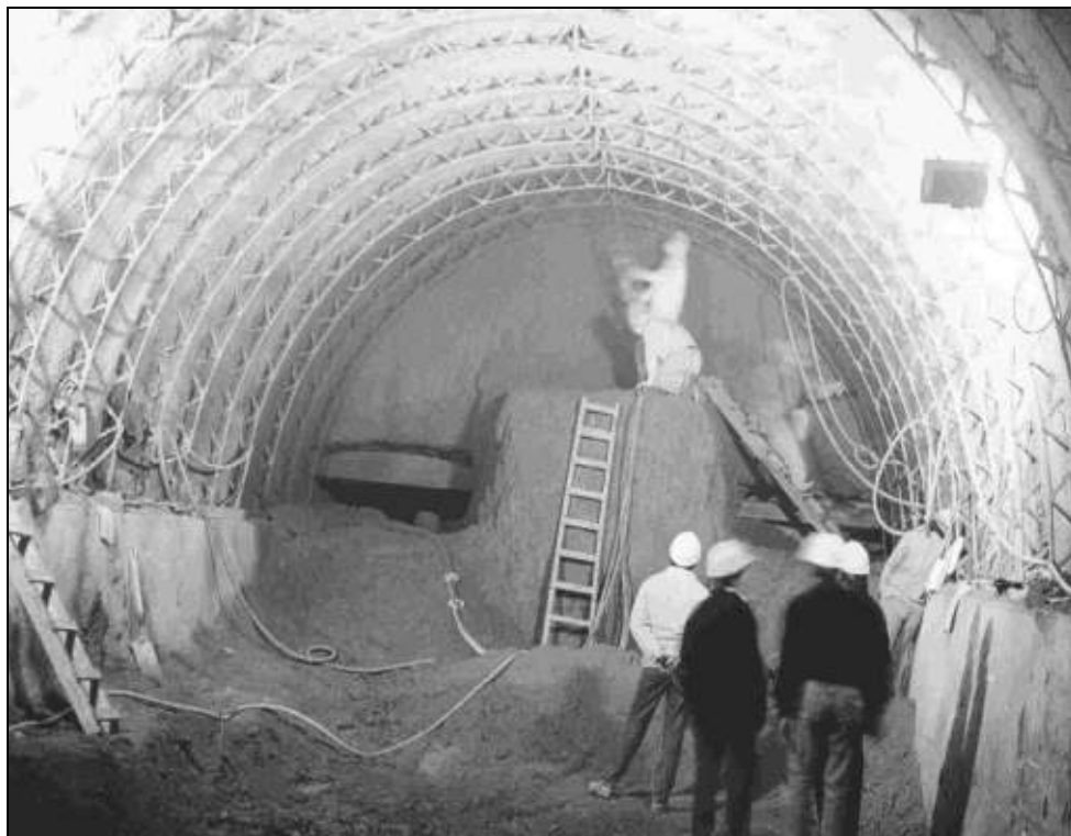
Fig. 1. Túnel Línea B, método alemán, 1999.
